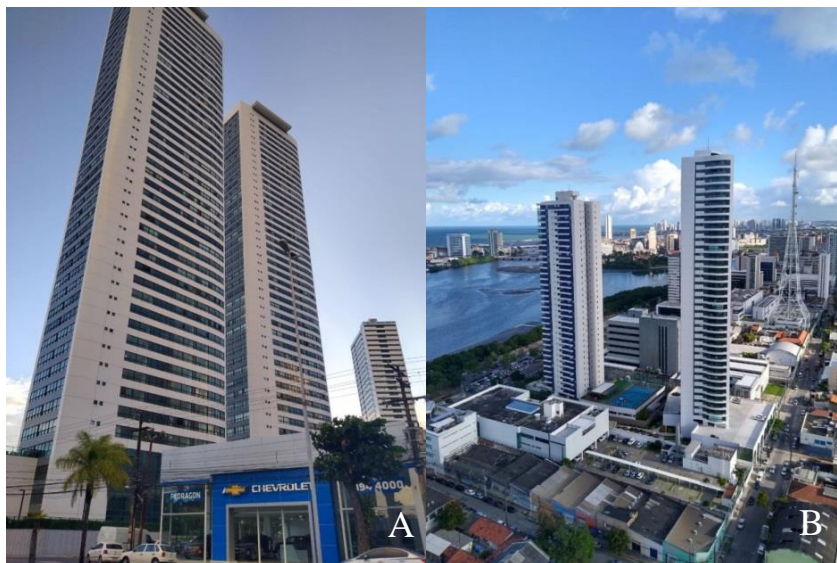
Figura 4 – Expansão da verticalização, onde: A= edifícios sequenciados em área anteriormente desvalorizada; B = visão de um setor do bairro Santo Amaro com mistura de gabaritos
